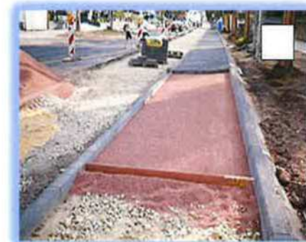
Sidewalk improvements/Mejoras de aceras
