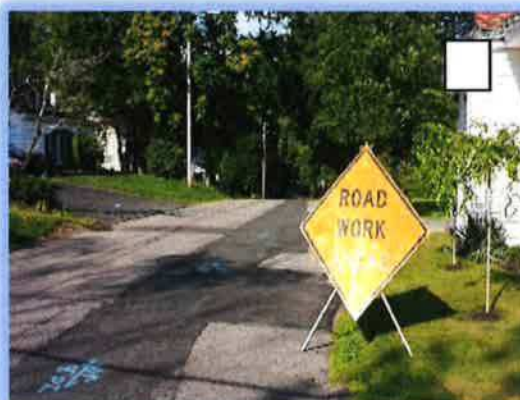
Road improvements/ Mejora de caminos
